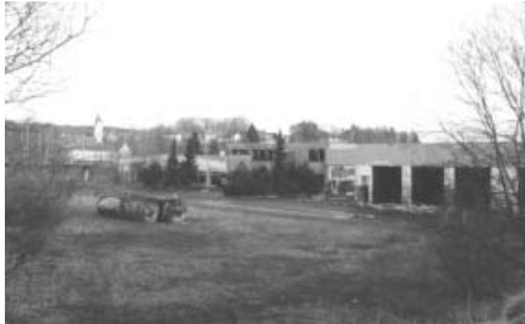
Eine Herausforderung für kluge Planung: Das brachliegende IVECO-Gelände
