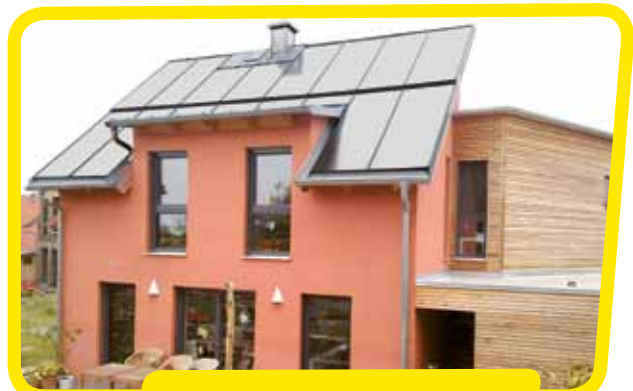
Beispiel für ein niedrigstenergetisches Wohnhaus (Quelle: natürlich-baubiologisch GmbH)
