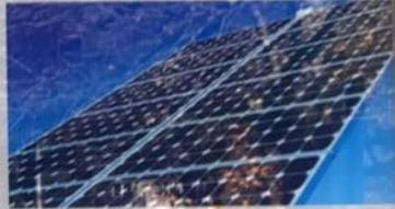
Unsere Solarstromanlage besteht aus 28 Solarmodulen mit einer Gesamtleistung von 4,48 kWp und einer Modulfläche von 38,4 m<sup>2</sup>. Sie ist in 4 Teilgruppen je nach Ausrichtung der Fenster auf dem Flachdach des Sommerhauses montiert. Sie wird im Jahr zwischen 3.300 und 3.800 kWh Energie erzeugen.
