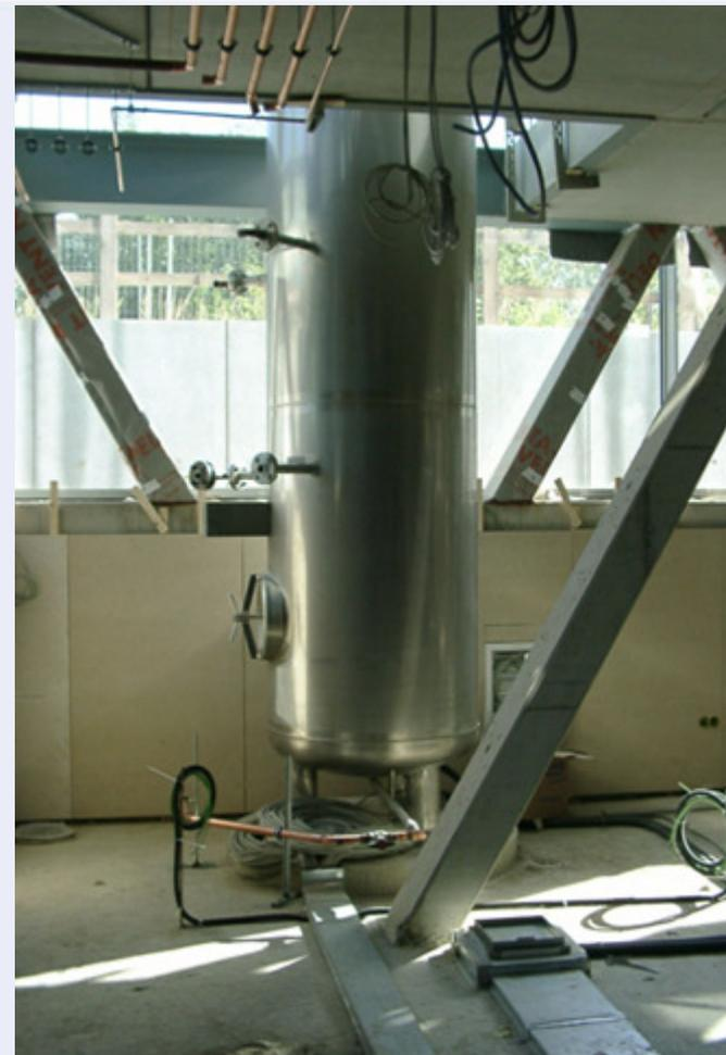
5 m<sup>3</sup> Pufferspeicher mit umlaufend 30 cm Dämmung
