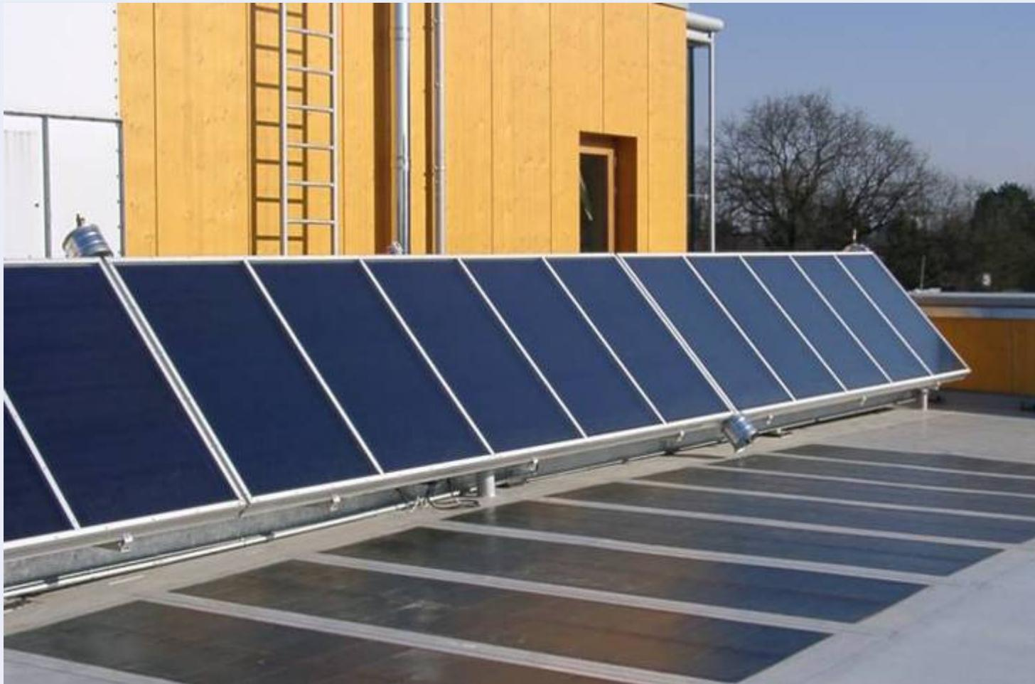
18 m<sup>2</sup> Flachkollektor für die solare Beheizung des Passivhauses (~250m<sup>3</sup>)
