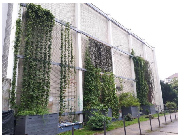
Abbildung 1: Verschiedene Fassadenbegrünungssysteme in Containern des Freiraumlabor der Technischen Universität Berlin
