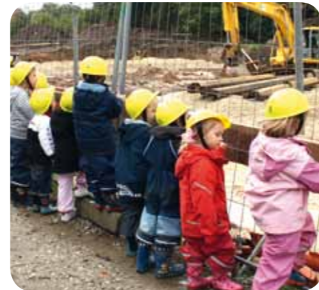
Die Kinder der „Kita Sattlertor“ schauen regelmäßig auf „ihrer“ Baustelle vorbei.
